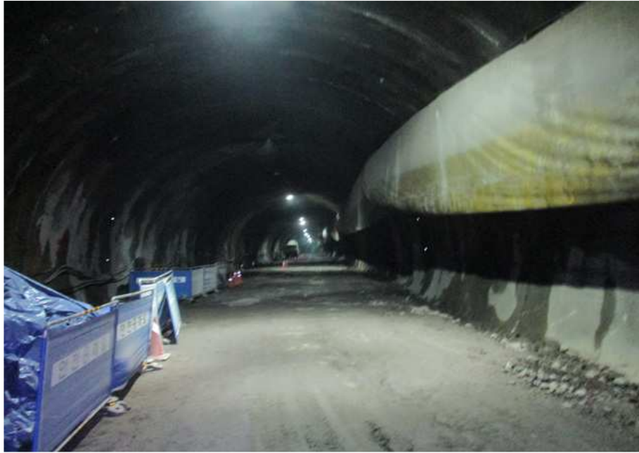
안전펜스 및 자재정리 현황
