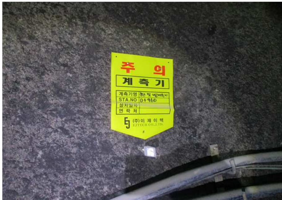
STA 0+960 내공 계측 현황
