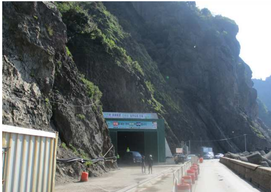
서면2터널 시점부 갱구 전경
