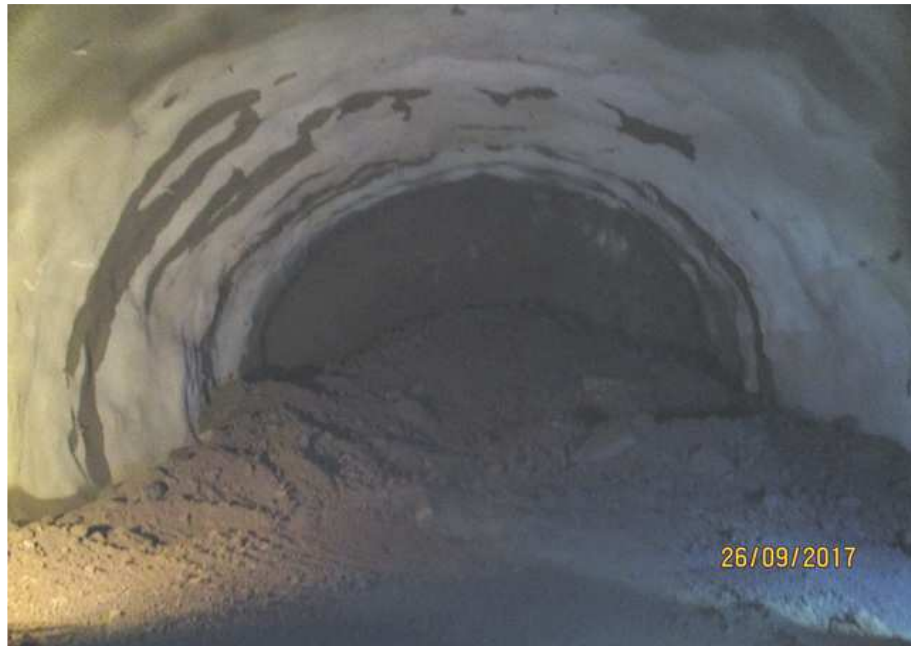
STA 0+910 터널 굴착 현황
