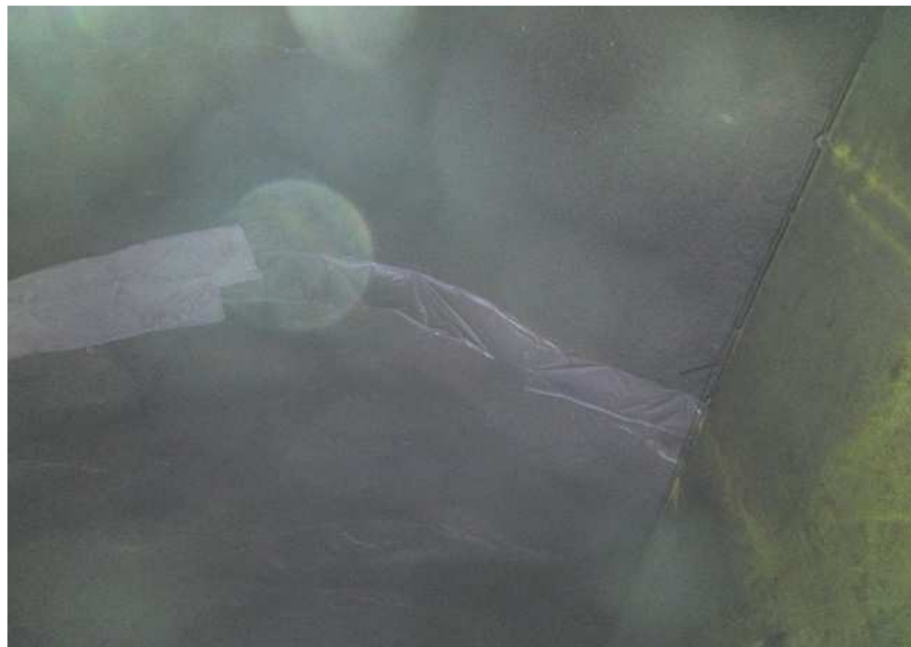
STA 1+040 방수막 설치 현황
