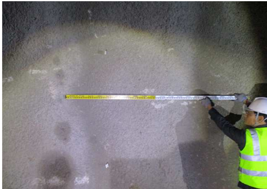
STA 0+900 ~ 1+100 터널 지보공 현황
