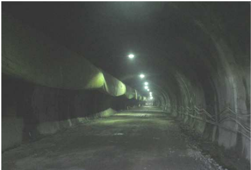
서면2터널 내부 전경
