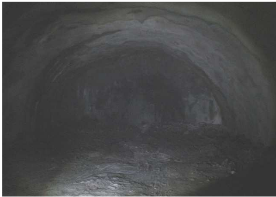
STA 1+120 터널 굴착 현황
