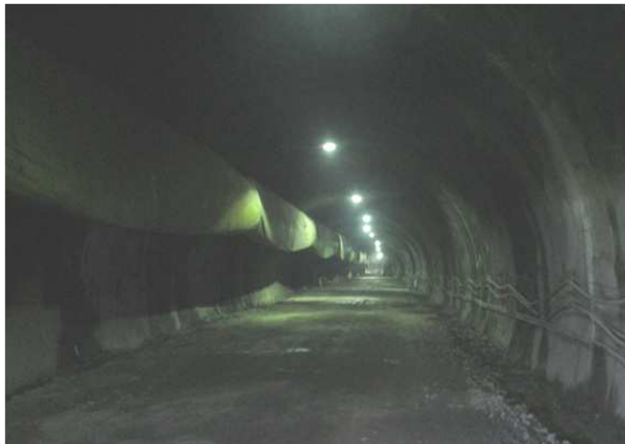
서면2터널 내부 전경
