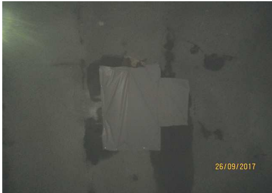
STA 0+850 방수막 설치 현황
