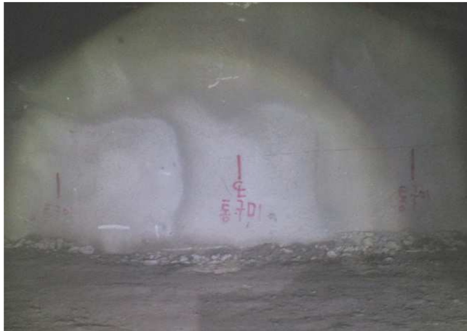
기존 통구미터널 교차구간 현황
