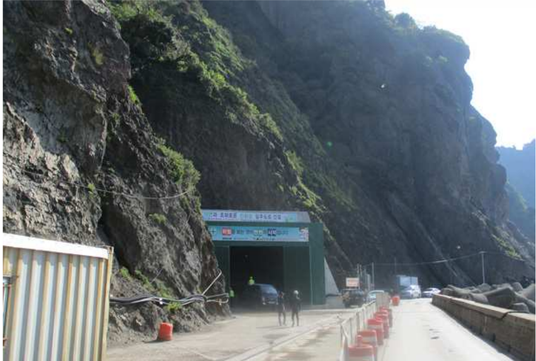
서면2터널 시점부 갱구 전경
