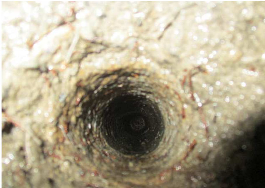
STA 0+900 ~ 1+100 터널 지보공 현황
