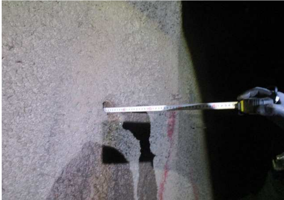
STA 0+900 ~ 1+100 터널 지보공 현황
